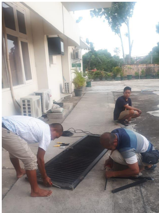
Foto no. 7 : PERBAIKAN PINTU TOILET RUANG MELATI
