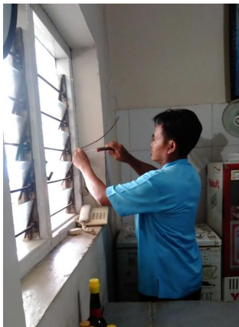
Foto No. 9: DOKUMENTASI SHARS (PENYAMBUNGAN ULANG KABEL TELEPON)
