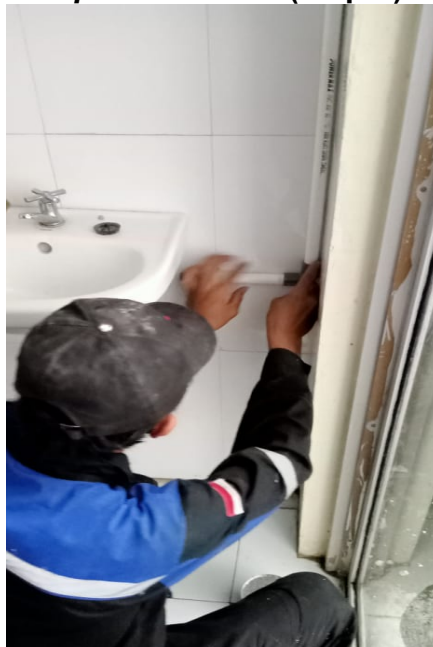
Foto No. 7: DOKUMENTASI E-SHARS (PERBAIKAN SALURAN AIR WASTAFEL CSSD)
