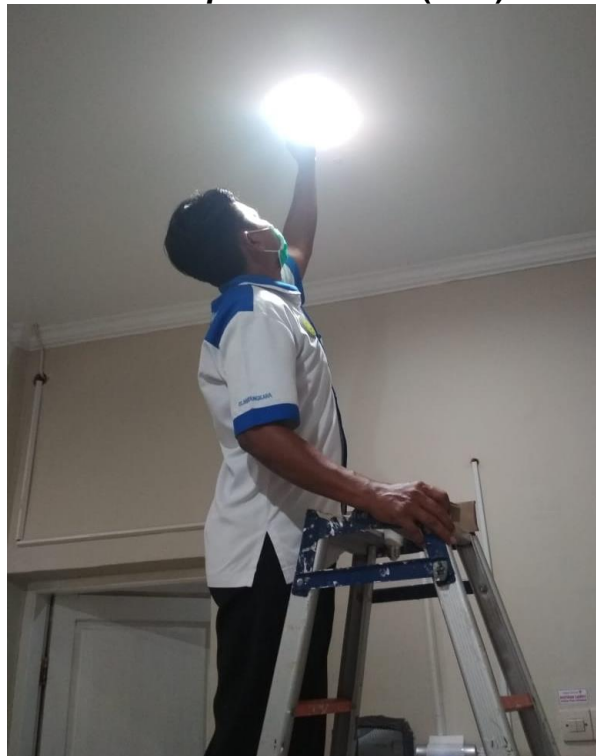
Foto no. 9 : PENGGANTIAN LAMPU DI RUANG JAGA (DOKUMENTASI SHARS)
