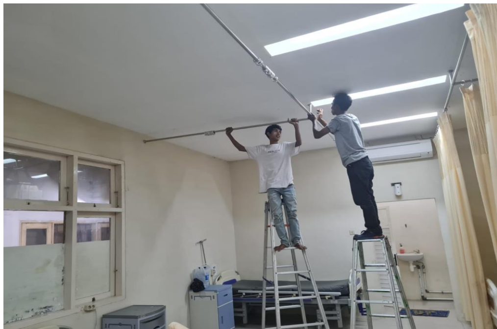
Foto no. 5 : PERBAIKAN REL KORDEN RUANG CEMPAKA 9 (DOKUMENTASI SHARS)
